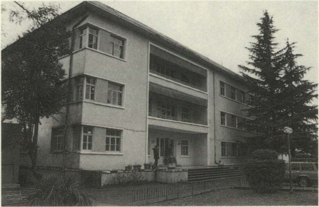
Das verkommene Gebäude wurde renoviert.
